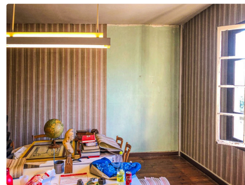
La salle du conseil pendant les travaux
