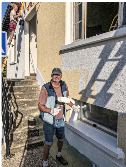
Peinture de la façade
