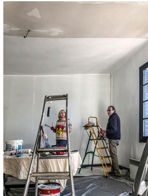
Le chantier avance
