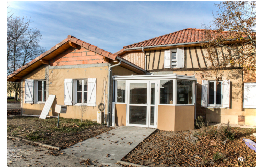
Façade avec le nouveau vestibule
