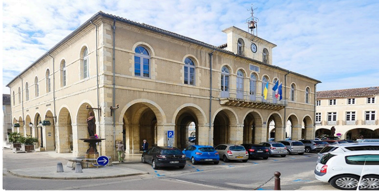
Travaux de l'Hôtel de Ville
