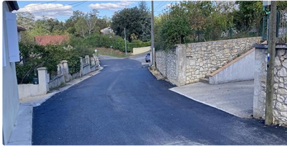
Les travaux de voieries avacent
