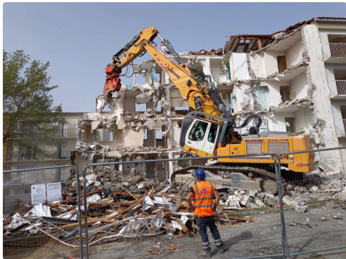
Démolition de la tour I.
