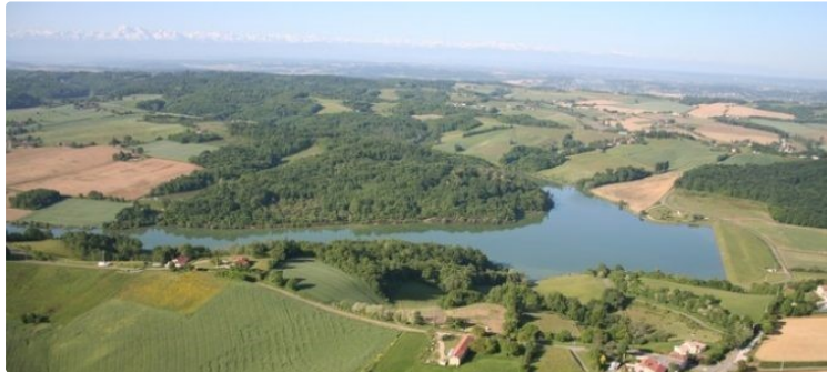
Projet photovoltaïque flottant
