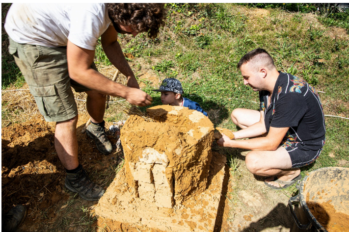
Construction d'un fourneau pour couler du fer
