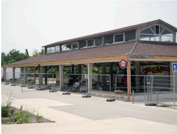
Début des travaux à la Halle au Gras : Réhabilitation en centre territorial de santé
