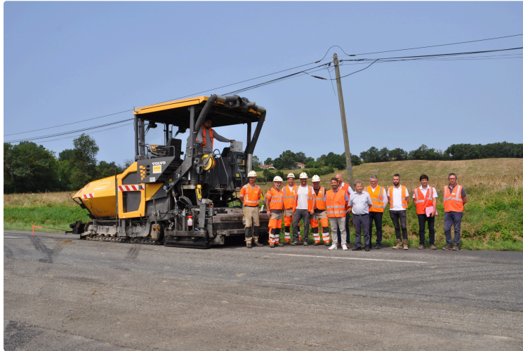
La RD 12 sur 1 km en test avec une nouvelle génération d'enrobés recyclés
