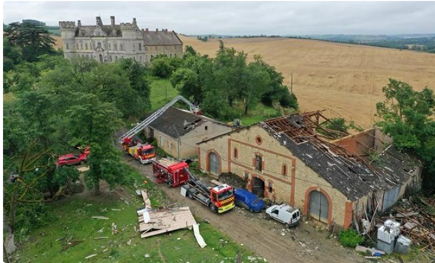
Les sapeurs-pompiers mobilisés suite aux évènements climatiques
