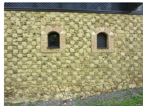
murs damiers 4.jpg
