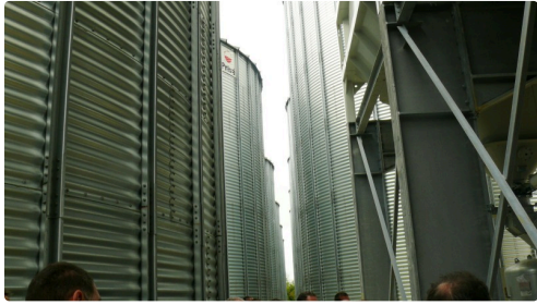
21 cellules de stockage pour recueillir 15 000 tonnes de céréales.
