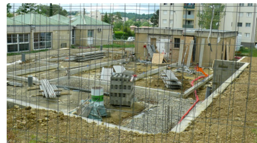
Les fondations de la nouvelle crèche.
