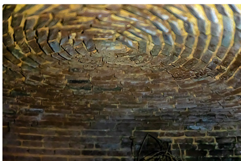
Intérieur du four à pain avant son démontage
