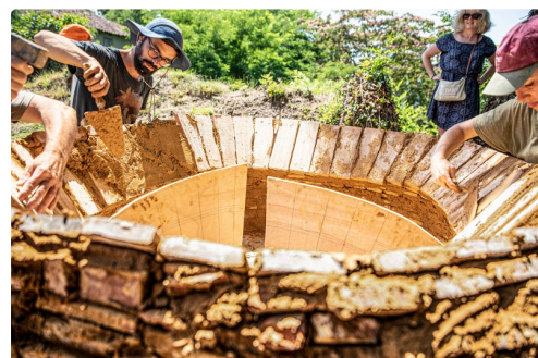
Le four en cours de reconstruction
