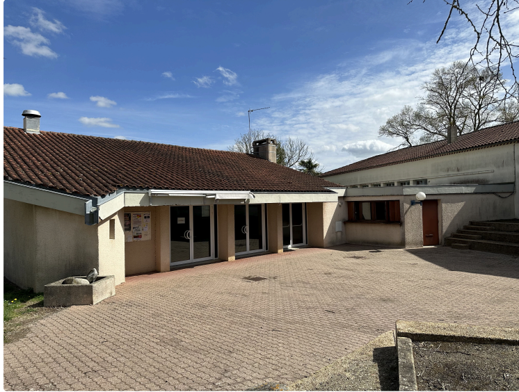
Réhabilitation complète de la salle des fêtes de Lagraulas
