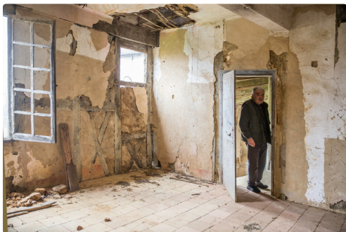
Au 1er étage; au fond, Pierre Barrail
