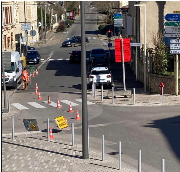
Travaux de voirie patience on arrive au bout
