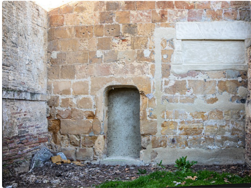
Partie du mur est de l'église (côté cloître)
