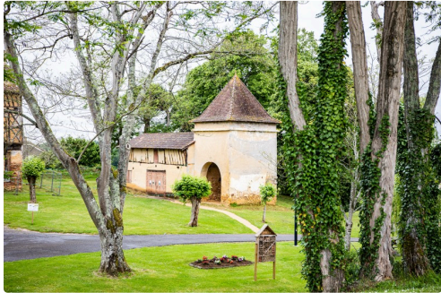
Le bâtiment de la Manse
