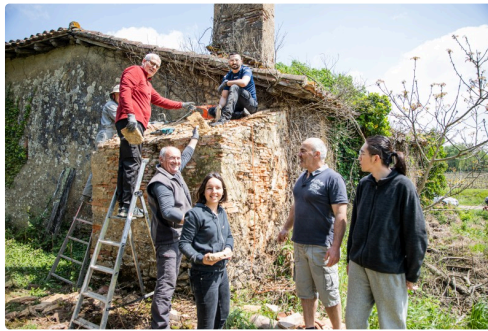
Le vieux four en cours de démontage ; Océane Gougeon au milieu
