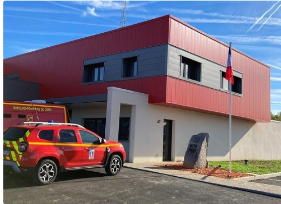
Nouveau centre d'incendie et de secours
