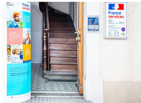
Entrée du bâtiment
