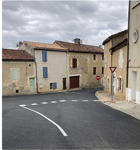
Les travaux de voierie avacent
