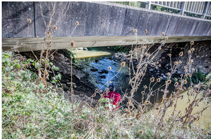
Sous le pont du Midour de la grand'route
