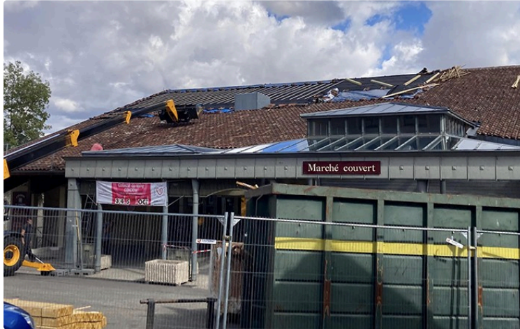
Travaux de la halle c'est parti
