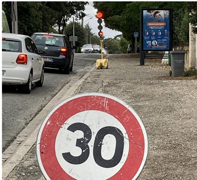
Les travaux de voierie avacent
