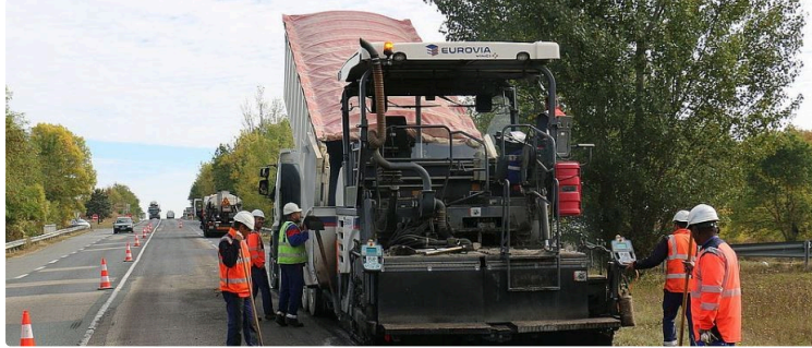
Travaux sur la RN 124
