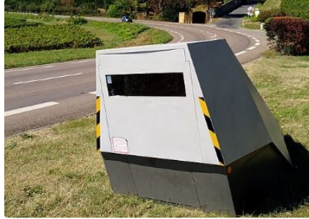
Dysfonctionnement du radar de Solomiac
