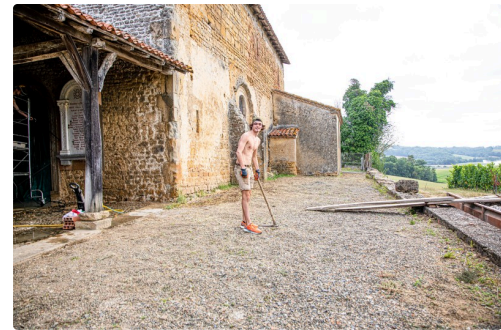
Ils ont débroussaillé cette surface
