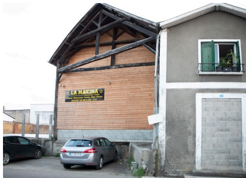
Le bâtiment de La Makina va jusqu'à la RD 43
