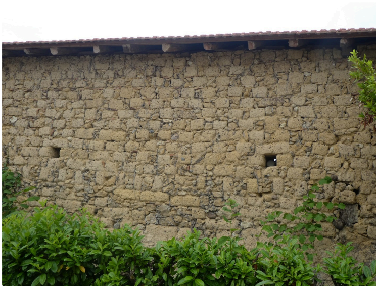
Rencontres de la Terre Crue en Occitanie avec Maisons Paysannes de France 32 & 65
