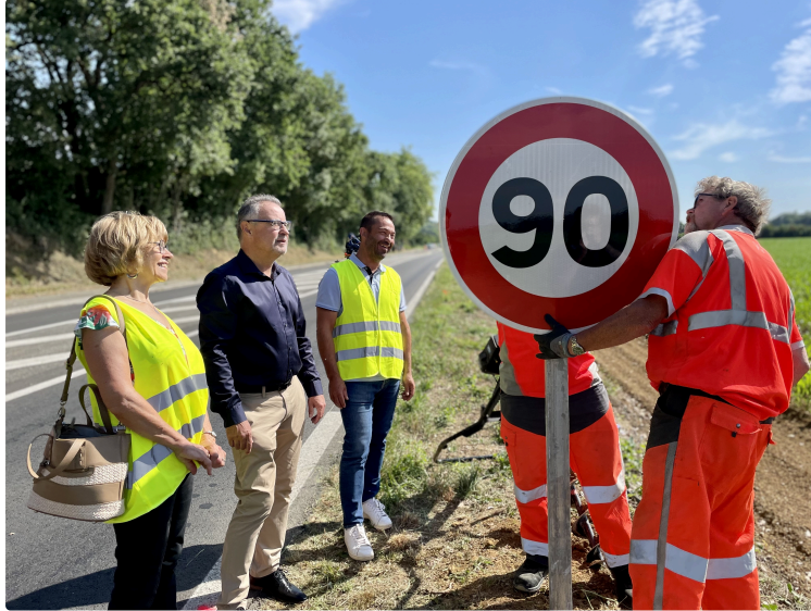
Le premier panneau 90 km/h vient d'être installé sur la RD 632 à Lombez
