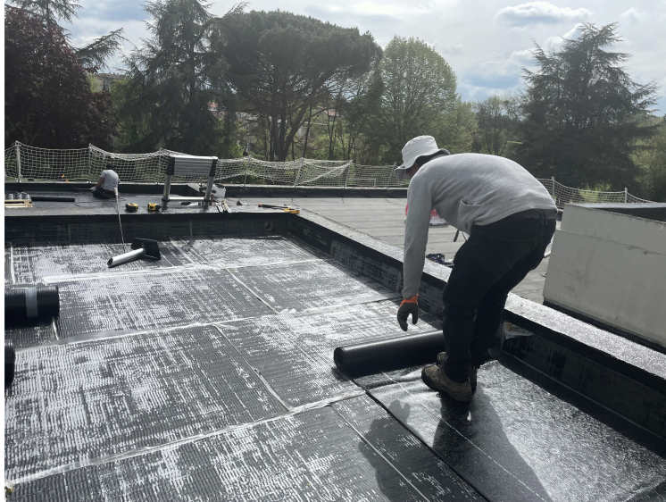
Rénovation énergétique de l'école élémentaire Marc Castex
