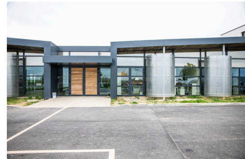
Centre de la façade
