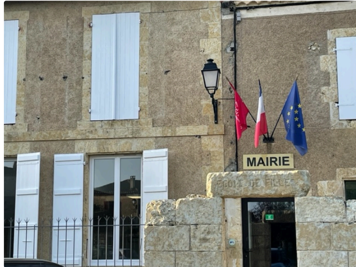
Réhabilitation de la mairie parmi les travaux 2021
