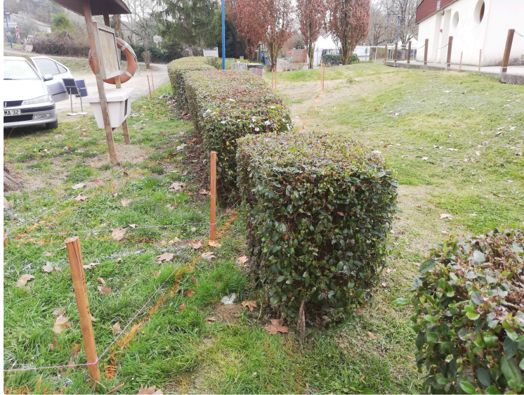
Travaux au port
