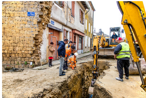
Les travaux dégagent un passage pour les canalisations
