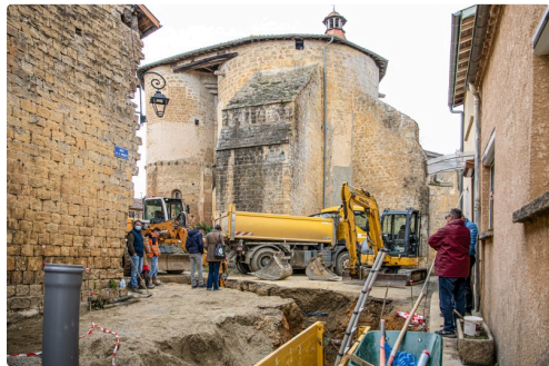
Le chantier vue de la rue de la Rampe
