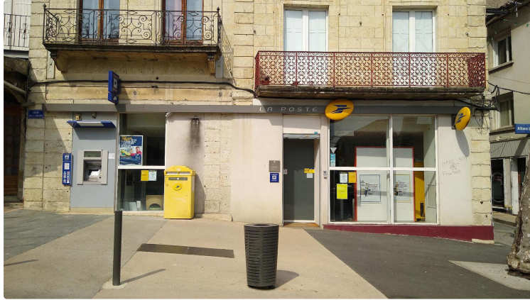
La Poste de Vic-Fezensac en travaux du 2 au 21 mars
