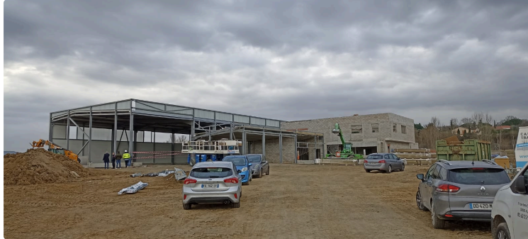
Le futur centre d'incendie et de secours de l'Isle-Jourdain sort de terre
