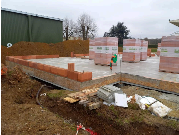
Au stade les travaux avancent
