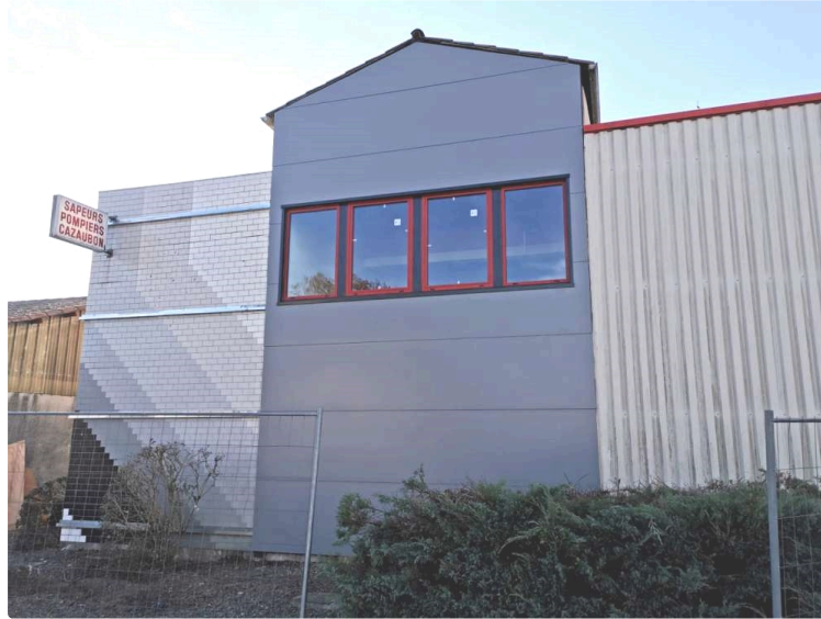
Le Centre de secours fait peau neuve
