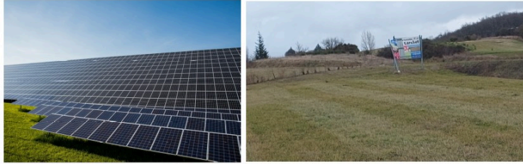
Opposition au parc photovoltaïque de Vic-Fezensac : les précisions des associations porteuses du recours
