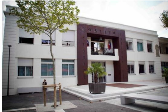
Vigilance orange crues pour la commune de Vic-Fezensac
