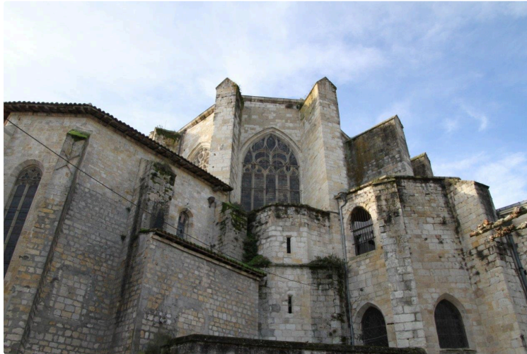
Des gros chantiers condomois, le plus important est sans conteste celui de la Cathédrale
