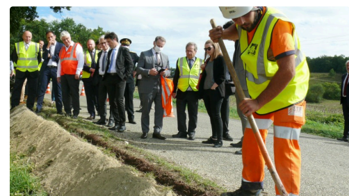
Les personnalités attentives au déroulement du chantier.
