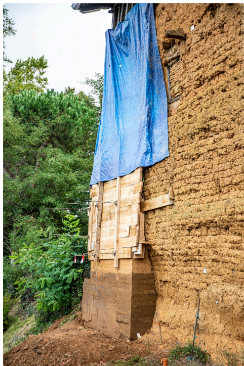
Les travaux du rempart sur la façade ouest
