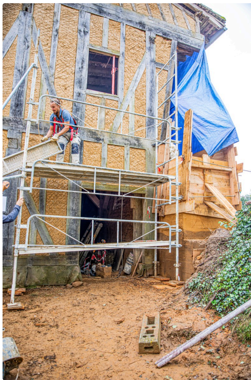
L'échafaudage sur la façade nord permet de monter la terre à droite
