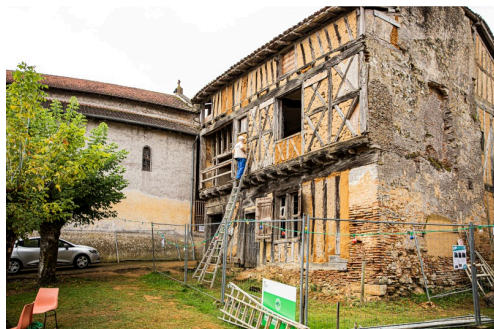
La façade est aussi en réfection
