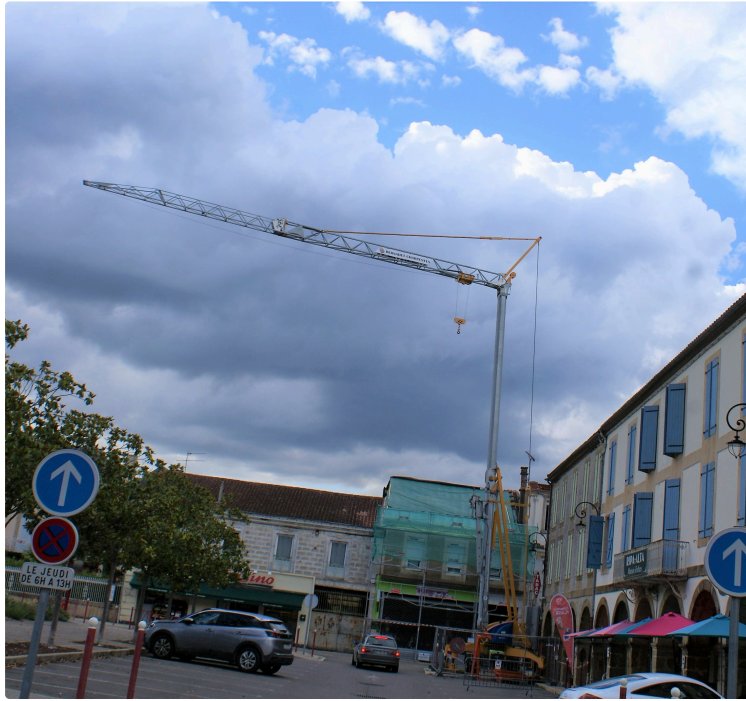
Une Grue dans les rues de la ville
