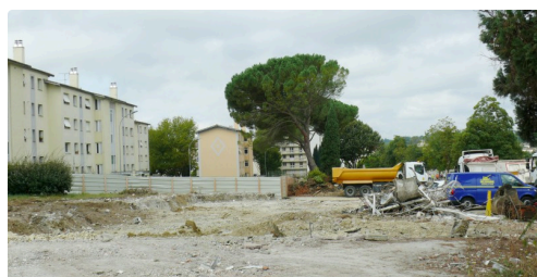
Les bâtiments ont disparu.
