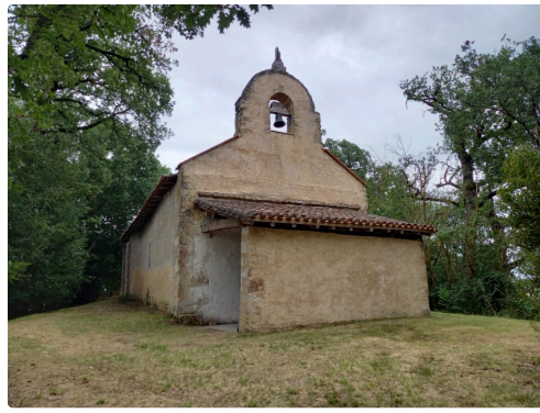
Façade ouest de la chapelle.
