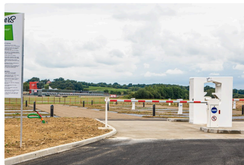
Vue du Parking des Oliviers
