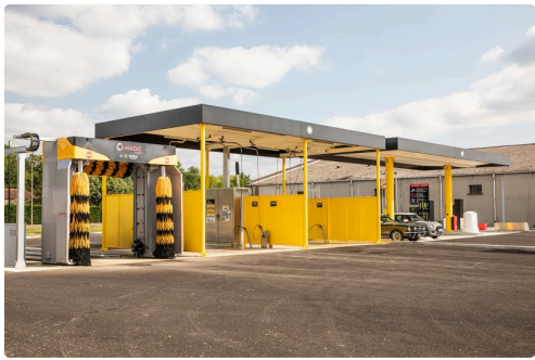
La station-service et sa station de lavage
