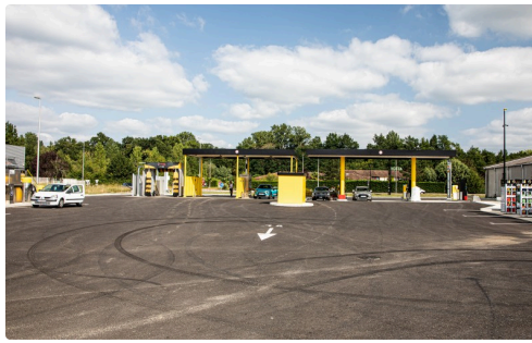
Vue de la station-service du côté opposé à la route
