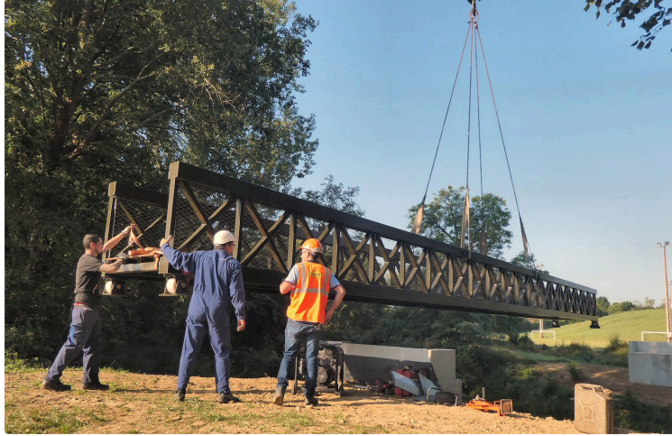
La passerelle des berges du Gers est en place
